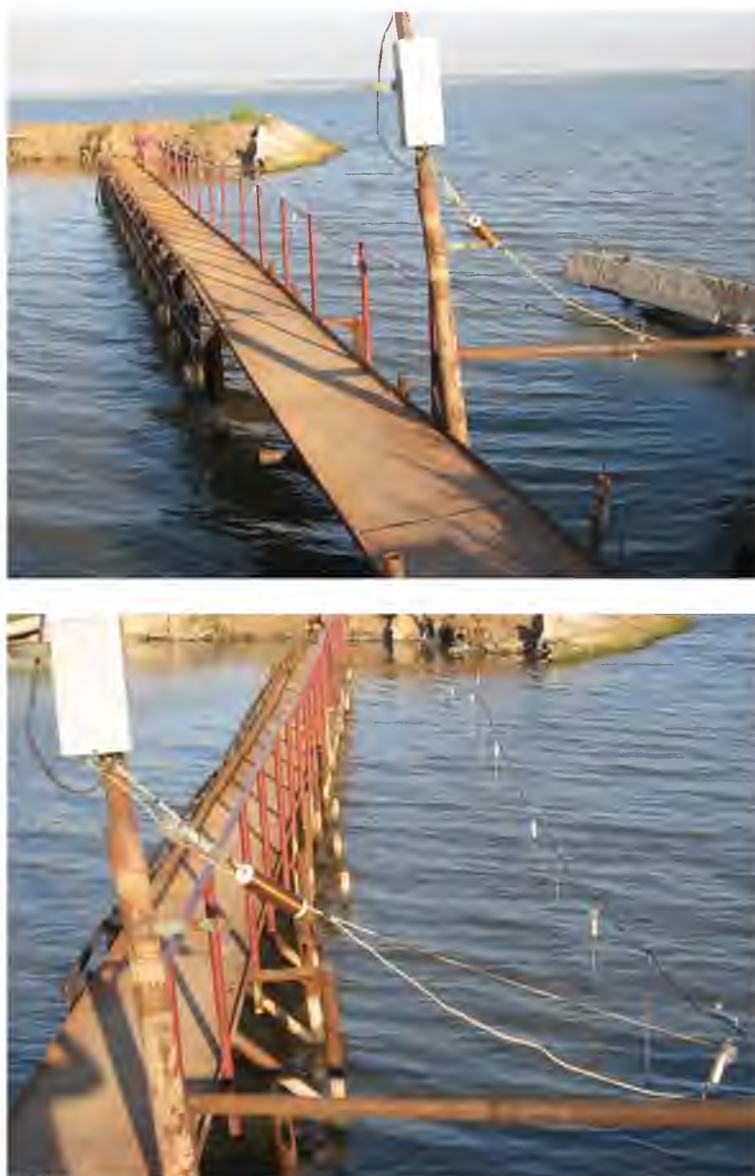
Рисунок 4.13 – Рыбозащитная система «ПИРС-2» на Миусской ОС
