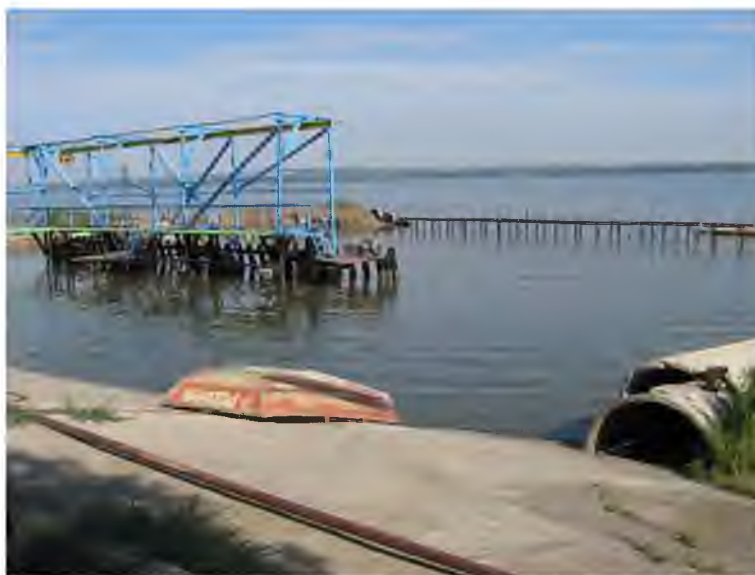
Рисунок 4.11 – Головная НС с рыбозаградителями, вынесенная за урез лимана
